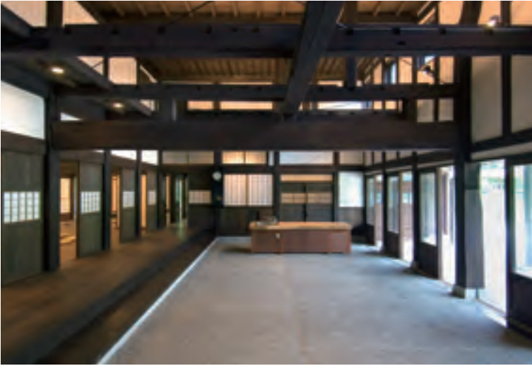
太く重厚な梁がこの家を支え続けている
