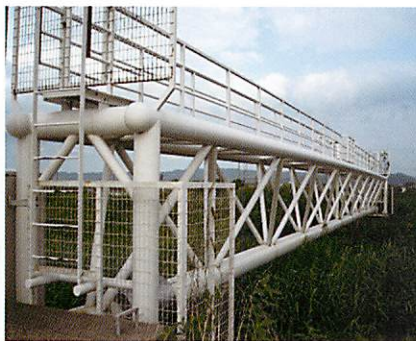
写真 - 1 A 水管橋
