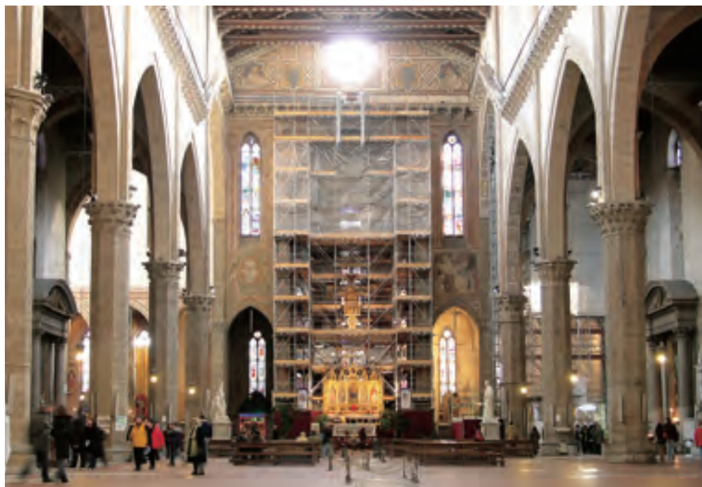
足場の高さは26メートル、9階建てのビルの高さくらいになる
