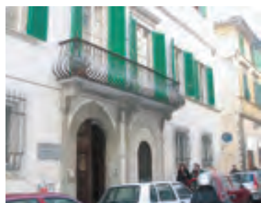
フィレンツェ大学の外観。看板が無ければ住宅アパートと見誤るほど、街に溶け込んでいる
