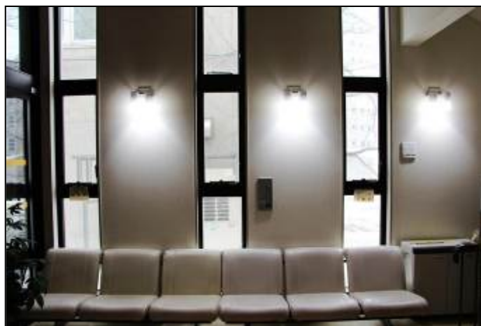
【入口ロビーの LED 照明】
