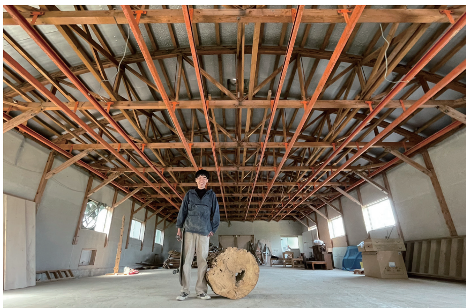
現在、改装中の新しい工房。アーチ型の屋根を持つ広々とした倉庫。
